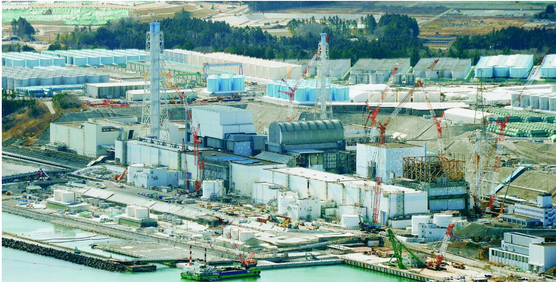
上空から見た福島第1原発。横に長いタービン建屋の奥に4基の原子炉建屋が並んでいます。(右手前から左奥に) 爆発で鉄骨がむき出しになった1号機、事故前の面影を残す2号機、かまぼこ形のドーム屋根が設置された3号機、四角いカバーで覆われた4号機の原子炉建屋。その奥には汚染水タンク群が見えます=2月5日(本紙チャーター機から佐藤研二撮影)
